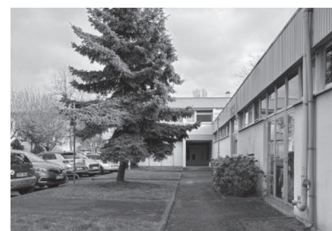
Figure 16 Implantation tramée du bâti Photographie Document personnel
