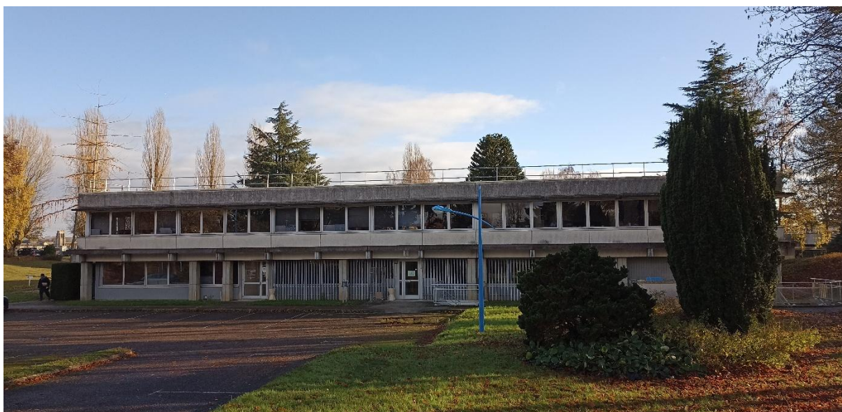
Figure 3 – Photographie de la façade Sud-Ouest de la CMAE, réalisation personnelle
