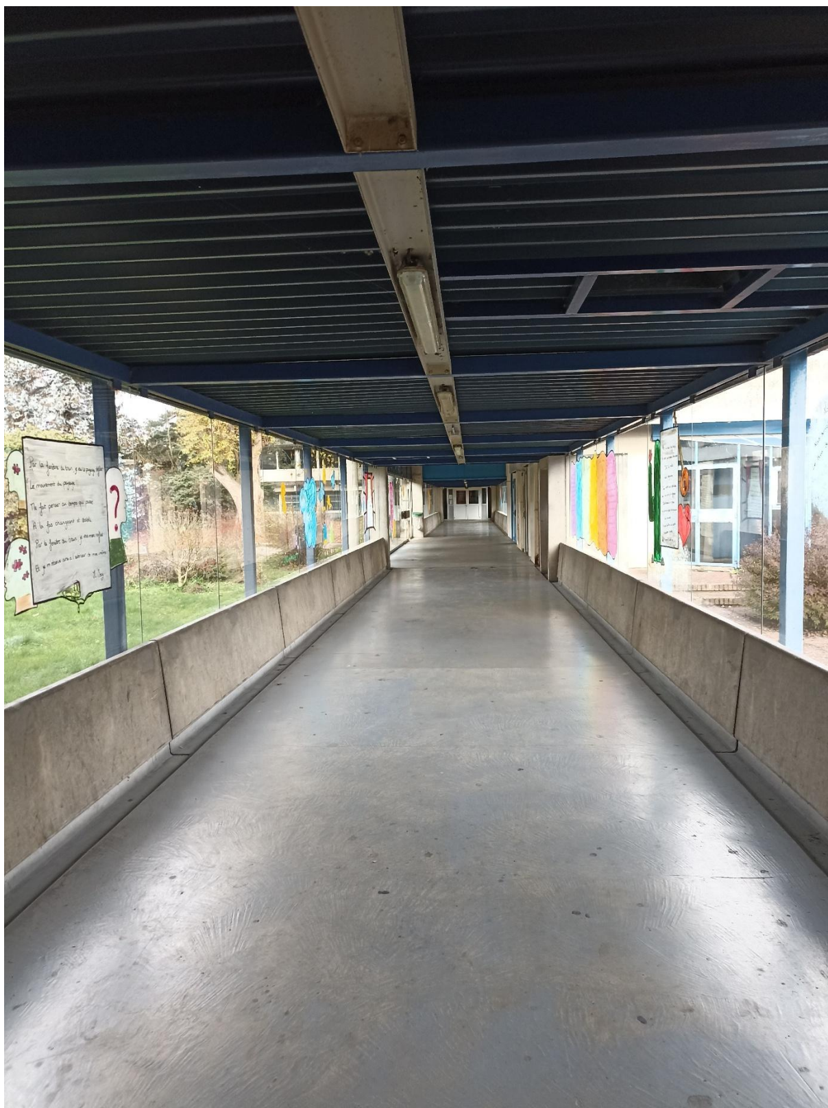
Figure 15 – Galerie d'accès à la CMAE - réalisation personnelle
