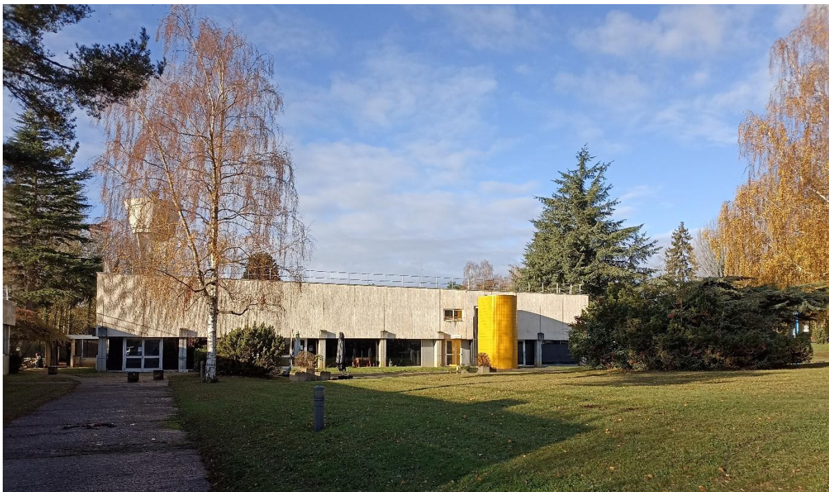
Figure 2 - Photographie de la façade Nord-Est de la CMAE, réalisation personnelle
