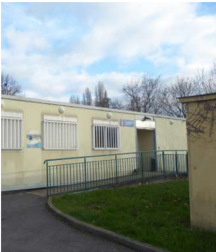
Le stockage médical et les garages
