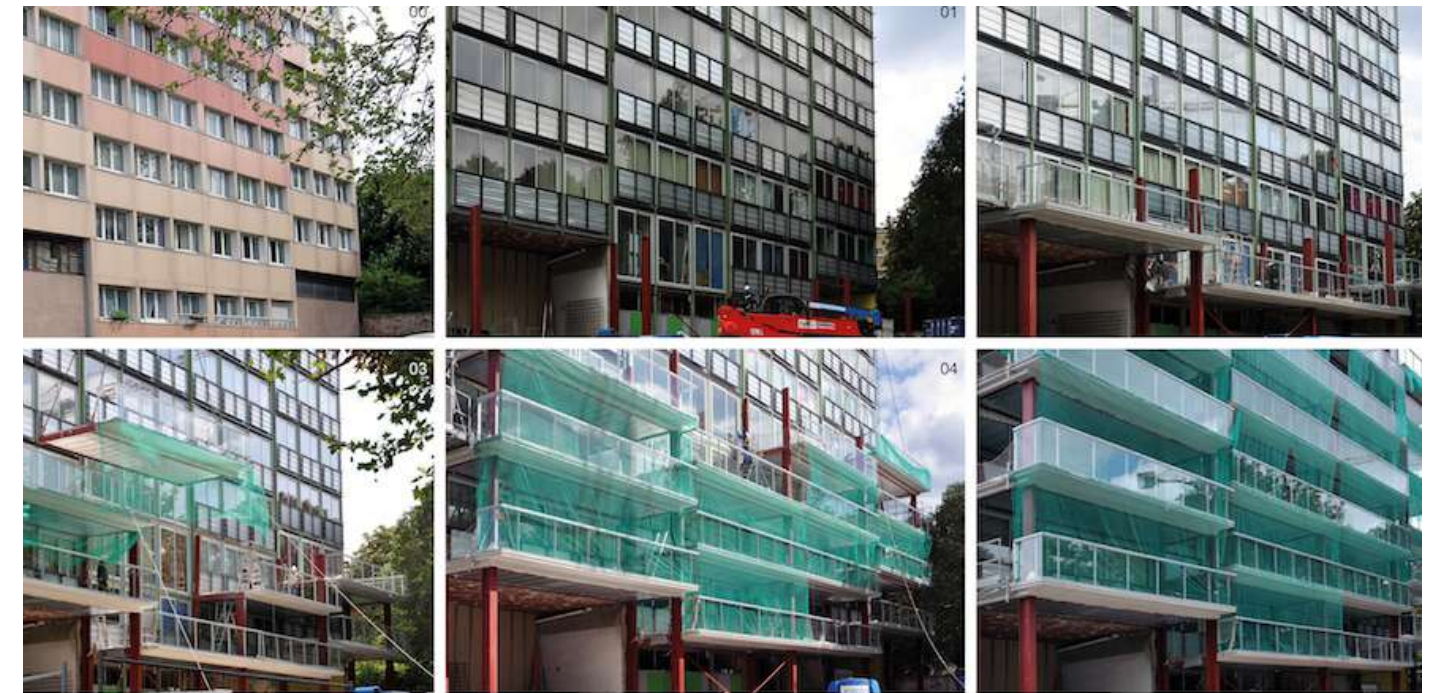
30. La tour bois le prêtre, en construction, source : lacaton et vassal
