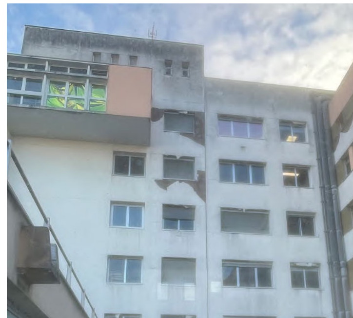
24. Photographie de la façade Ouest du bâtiment central d'origine altéré par le temps (fig.2)
