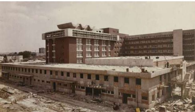
20. Photographie personnelle du bâtiment d'origine (1975) et photographie du chantier en 1970 (APHP)
