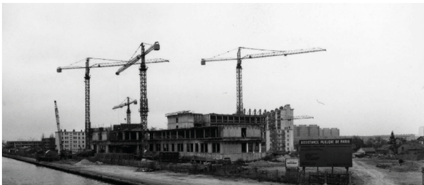
13. Photographies des archives de l'APHP (1960-70) - Friche et futur terrain de l'Hôpital - Terrain en construction
