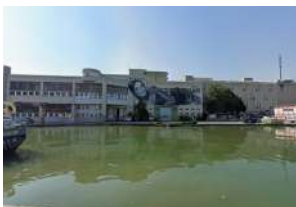
Entrepôts / bureaux à Pantin
