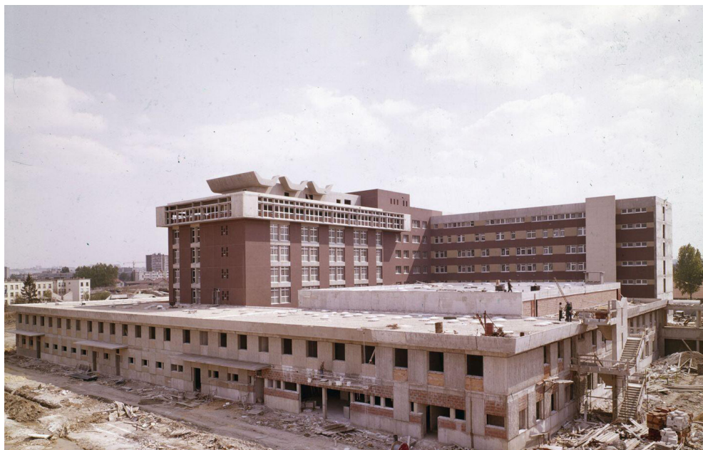
Fig 52 : La façade nord ocre rouge du bâtiment principal © Archives de l'AP-HP
