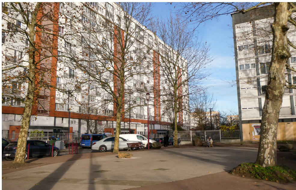
Fig 22 : Des places bitumées à Bondy Nord
