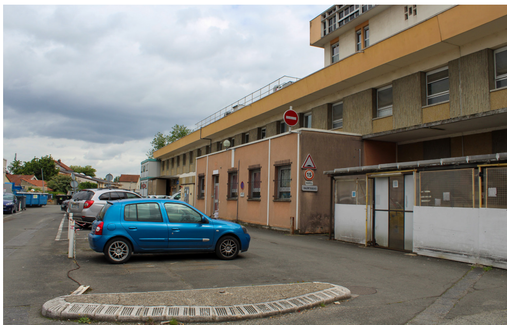
Fig 62 : Le bâtiment en L, façade nord
