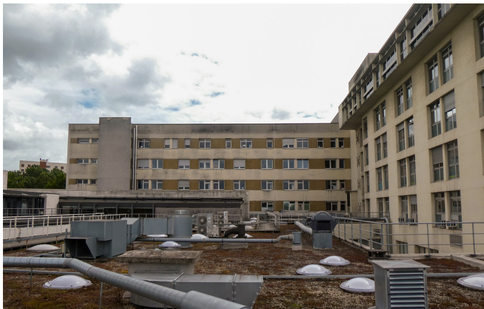
Fig 7 : La partie arrière de l'hôpital, interface avec le nord de Bondy
