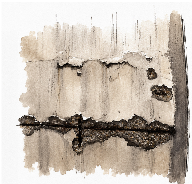
Corrosion des armatures métalliques du béton armé
