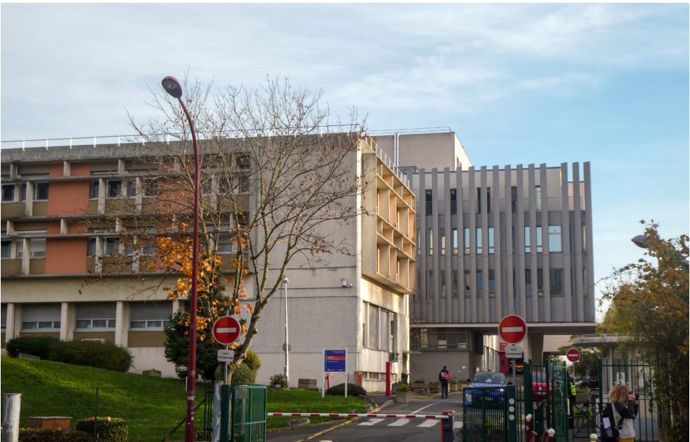
Fig 6 : L'entrée Sud-Ouest de la parcelle, à l'avant du site, interface avec le canal
