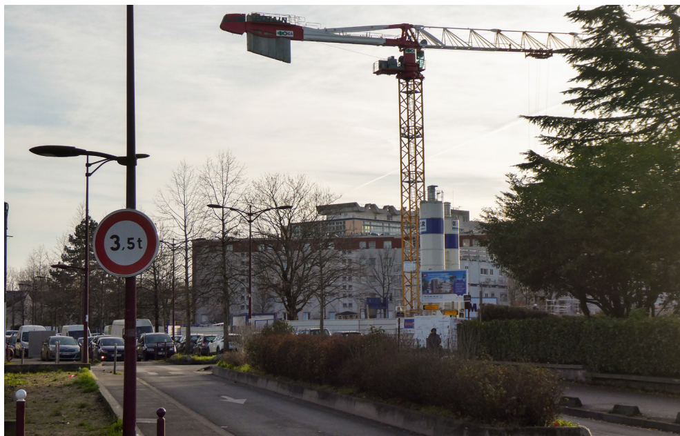
Fig 3 : L'hôpital comme repère dans le tissu urbain du Nord de Bondy
