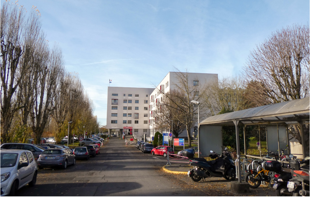
Fig 5 : L'entrée Sud-Est de la parcelle, à l'avant du site, interface avec le canal
