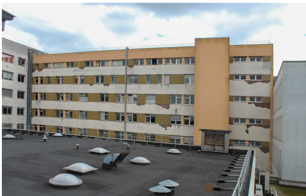
Fig 53: La façade nord du bâtiment principal en 2026
