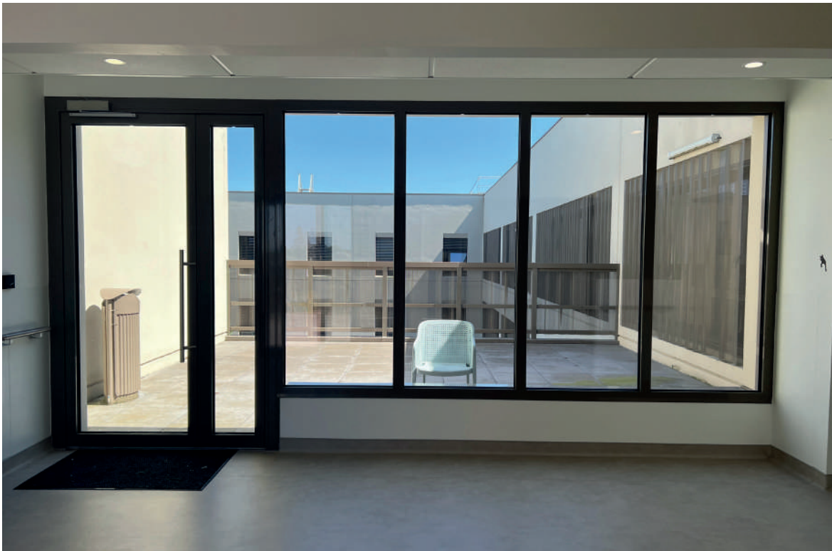
[fig. 114] Proposition d'aménagement d'un espace non utilisé et de sa terrasse. Avant/après. RETEX AIA Life Designers, septembre 2025.
