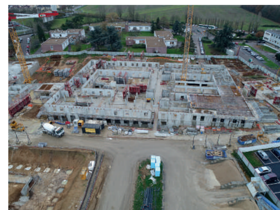
[fig. 58] Construction du nouveau centre en milieu occupé. On peut apercevoir les pavillons du village 1 en arrière plan. Photographie de Stéphane Levy.
