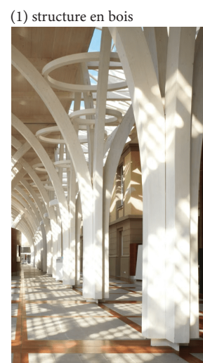
(1) structure en bois
