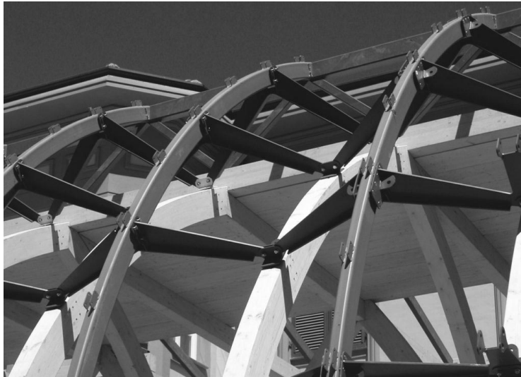
► Fig. 16 Photographie du chantier de l'atrium, AEI progetti
