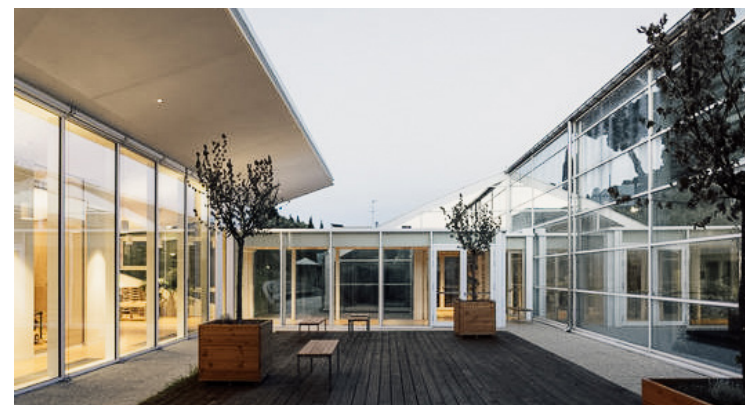
Fig. 81 Cappelletti Marco, photographie du patio, 2024
