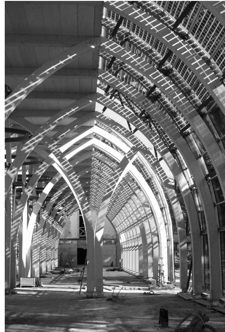
◀ Fig. 17 Photographie du chantier à l'intérieur de l'atrium, AEI progetti
