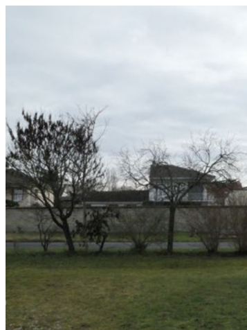
Vue du mur d'enceinte cerclant le périmètre du site, CHTR, 2025.
