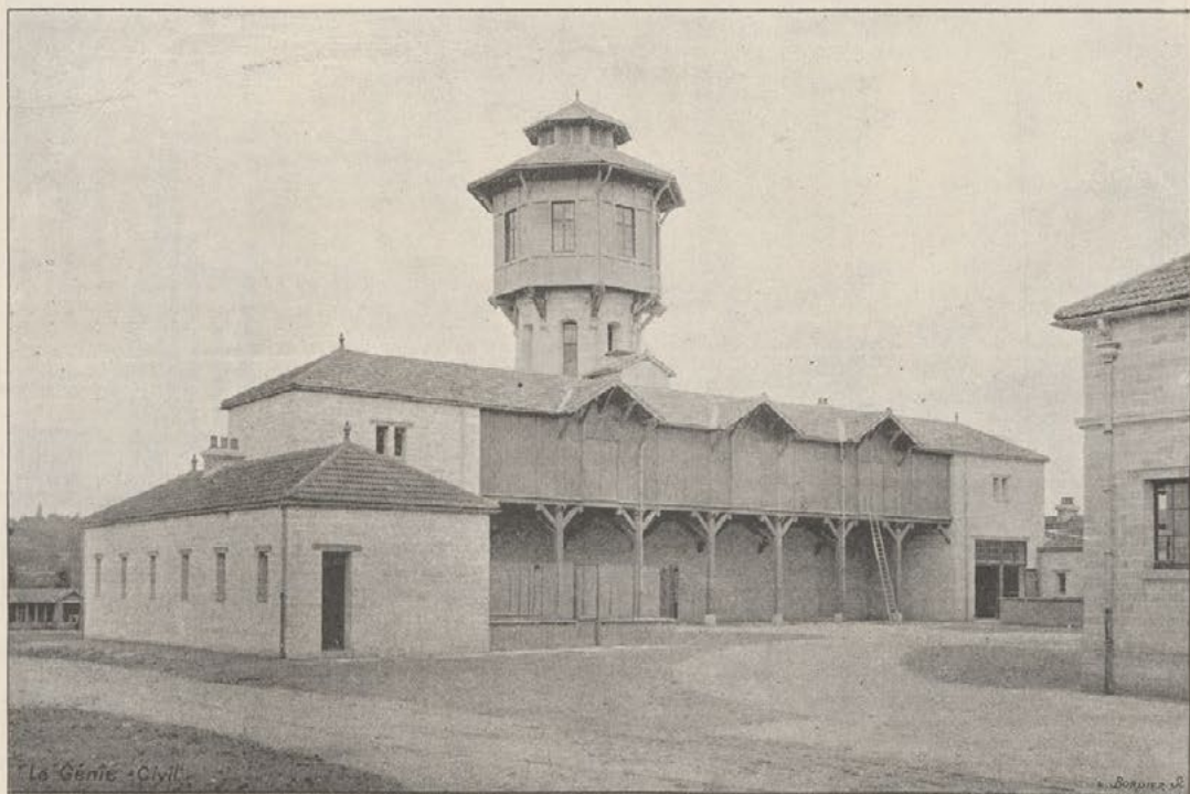
Fig. 4. — Hangar et château-d'eau de la ferme de l'établissement de Montesson.
