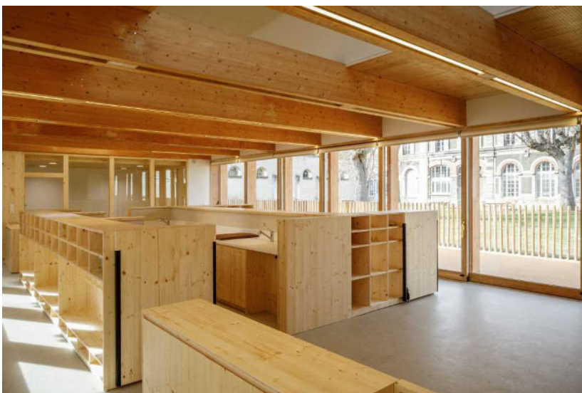
Fig. 23 Vue intérieur, Crèche 24 berceaux – Palais de l'Alma, Paris 7e, 2022.
