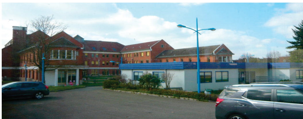
Fig. 07 Photographie du bâtiment d'enseignement, démolition, réalisation personnelle.
