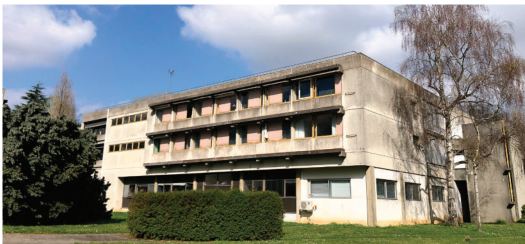
Fig. 27 Photographie de bâtiment H5, les pilotis ont été comblés, réalisation personnelle.
