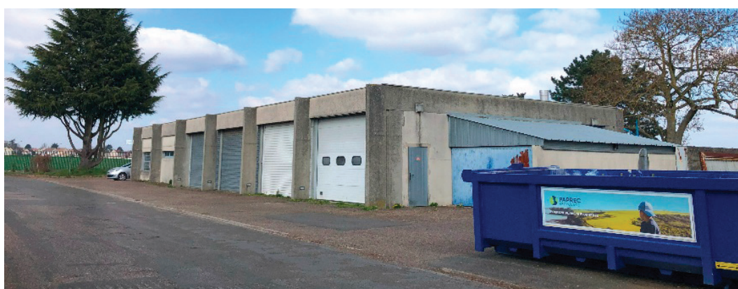
Fig. 10 Photographie du bâtiment des services techniques garage, réalisation personnelle.
