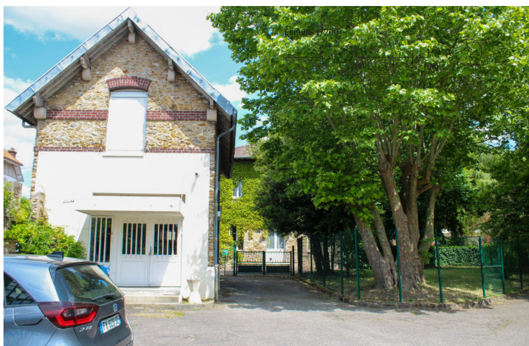
Fig. 15 Façade ouest des logements, transformations en façade du logement de gardien, photographie de juin 2025, réalisation personnelle.
