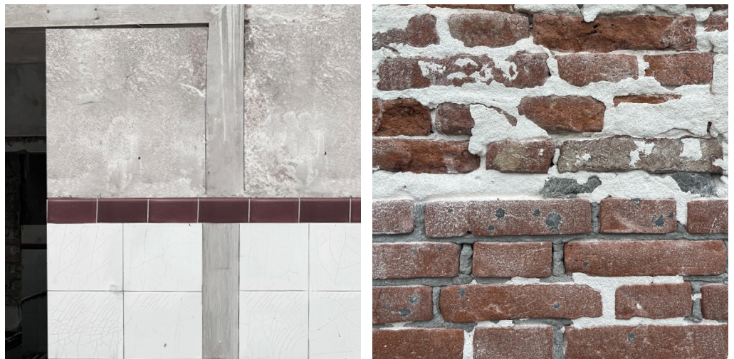
fig 26&27 : Calpinage de faïence blanche et des briques extérieures [photographies numériques personnelles]
