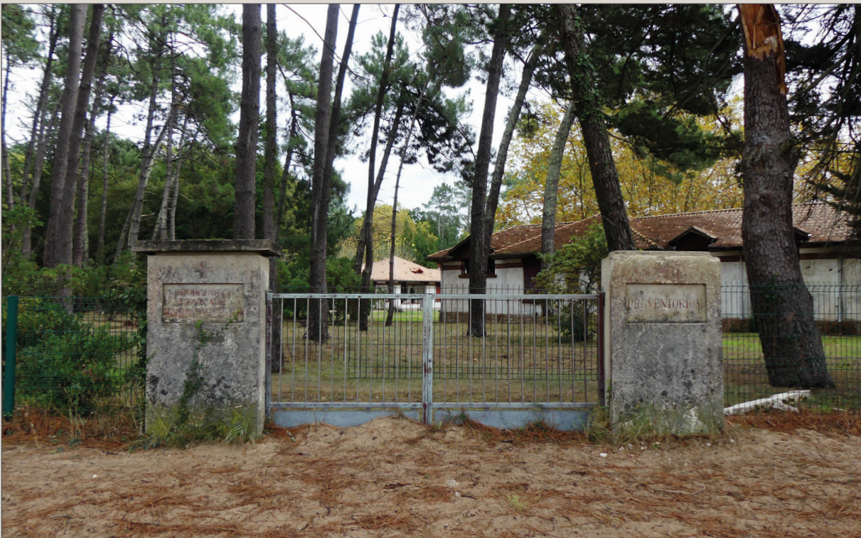
fig.10 - Accès condamné Photographie personnelle.
