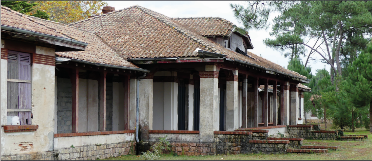
fig.74 - La galerie de cure du bâtiment principal Photographie personnelle.
