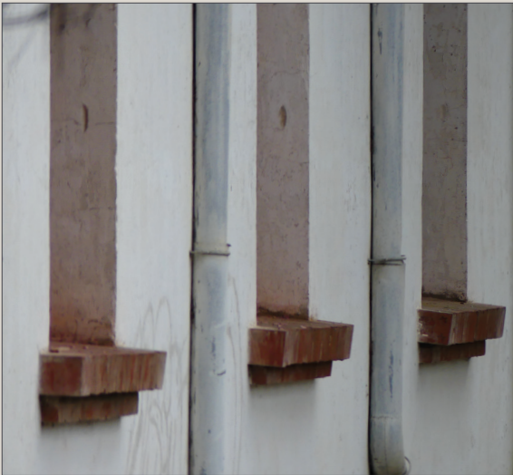
fig.75 - Appuis de fenêtre Photographie personnelle.
