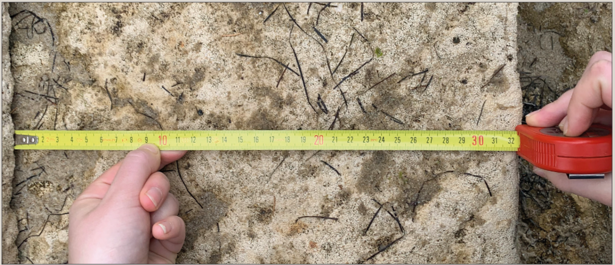
fig.78 - Relevé de l'escalier inaugural Photographie personnelle.
