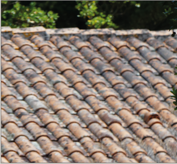
fig.47 - Les toitures Photographie personnelle.
