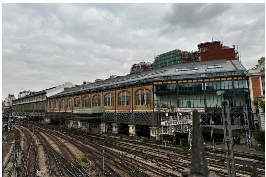
La façade sud-est de la halle de l'Europe depuis la place de l'Europe
