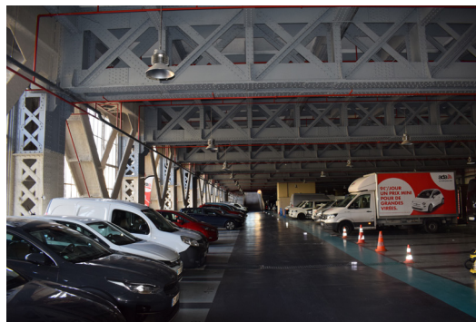
Les poutres treillis au R-1 de la halle des Batignolles
