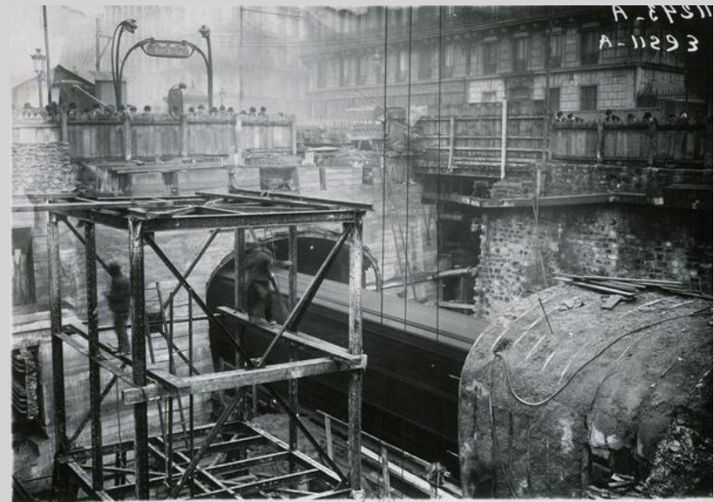
Figure 10 - Chantier du tunnel des Batignolles, 1923-1925, © Gallica, photographie de presse, Agence Meurisse
