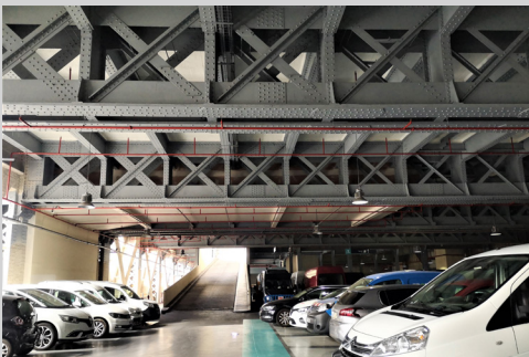
Figure 36 - Parking de La Poste au rdc, © photo personnelle
