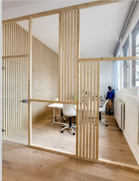
Figure 66 - Claustre en tasseaux et vitres, laissant ainsi passer les vues et la lumière, © Celia Masseboeuf
