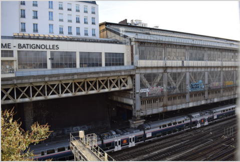
Figure 34 - La façade donnant sur les voies ferrées, © photo personnelle
