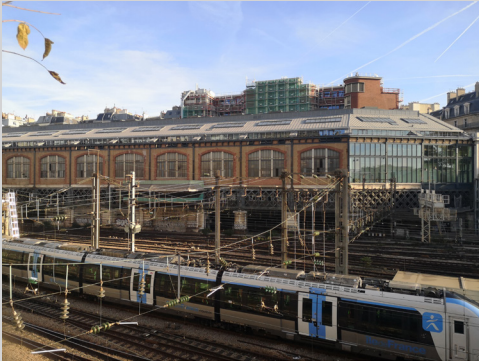
Figure 29 - La façade donnant sur les voies ferrées, © photo personnelle
