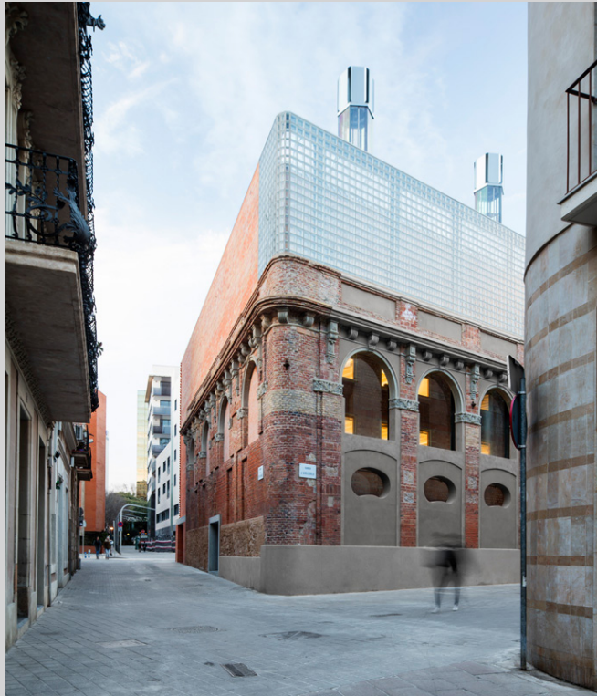
Figure 45 - En haut la façades des Cristalleries Planelle depuis la rue, les murs anciens de briques laissent deviner une double peau.
