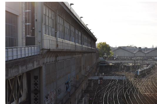
Les voies ferrées qui mènent à la gare Saint-Lazare au pied des Messageries
