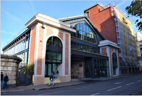
Figure 28 - L'unique entrée de la halle rue de Saint-Petersbourg © photo personnelle
