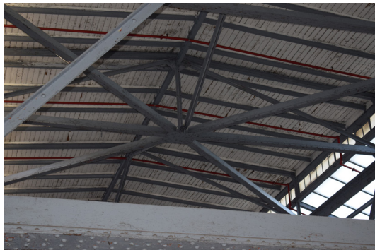
Noeud remarquable dans la charpente métallique de la halle des Batignolles
