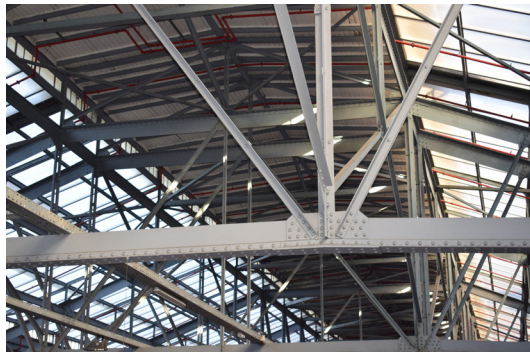
La charpente ensoleillée de la halle des Batignolles
