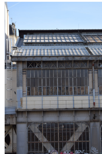
Morceau de façade de la halle des Batignolles
