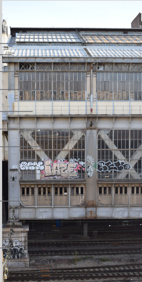
Figure 26 - Façade de la halle des Batignolles et ses matériaux, © photo personnelle
