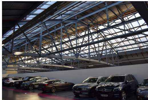
La charpente métallique dans le parking de la halle des Batignolles
