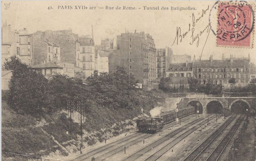
Figure 9 - Le Tunnel des Batignolles, 1923-1925, © La France ferroviaire en cartes postales
