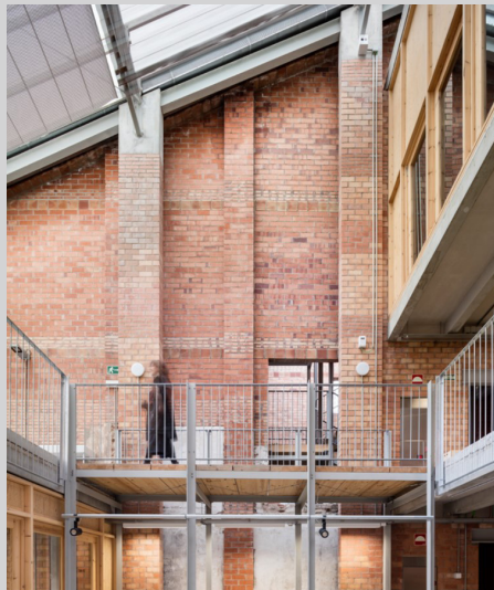
Figure 68 - Vari t  des mat riaux du hall du Centre civic Lleialtat Santsenca 1214, Barcelone, © Harquitectes
