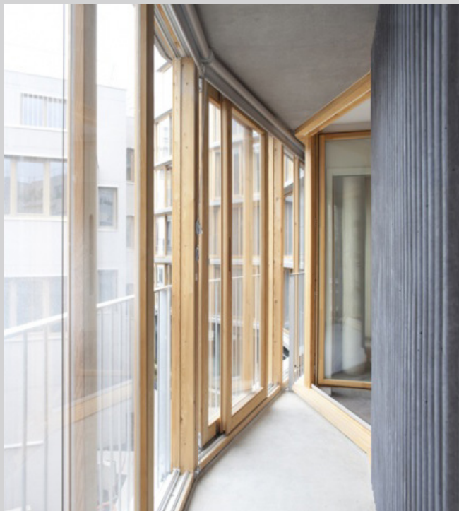
Figure 47 - En haut vue de l'entre deux peaux, utilisée comme véranda et du «mur capteur» noir. En bas une vue de la façade une fois les store dépliés © Gérard Clément
