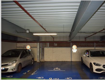
Figure 22 - Mur arrière au Rdc - halle des Batignolles © photo personnelle
