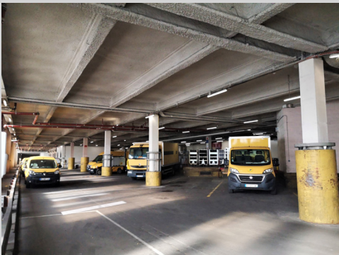
Figure 31 - Parking de La Poste au rdc, © photo personnelle
