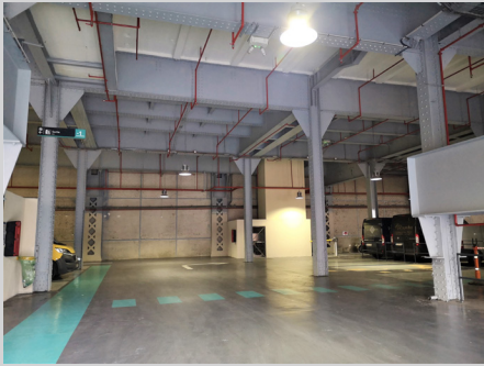
Figure 21 - Mur arrière au R-1 - halle des Batignolles © photo personnelle
