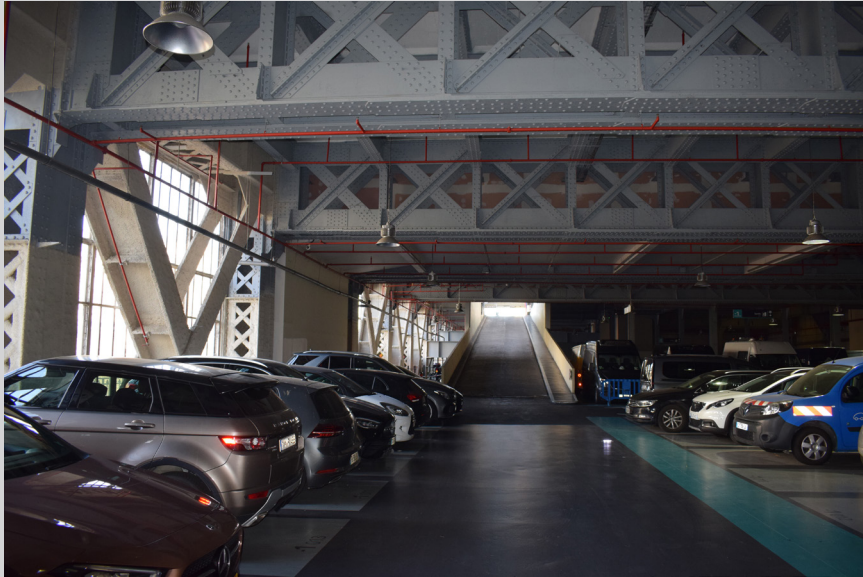
Figure 42 - Au R-1 de la halle des Batignolles, nous sentons qu'un côté est très vitré et lumineux, alors qu'un autre sans ouverture est très sombre, © photo personnelle
