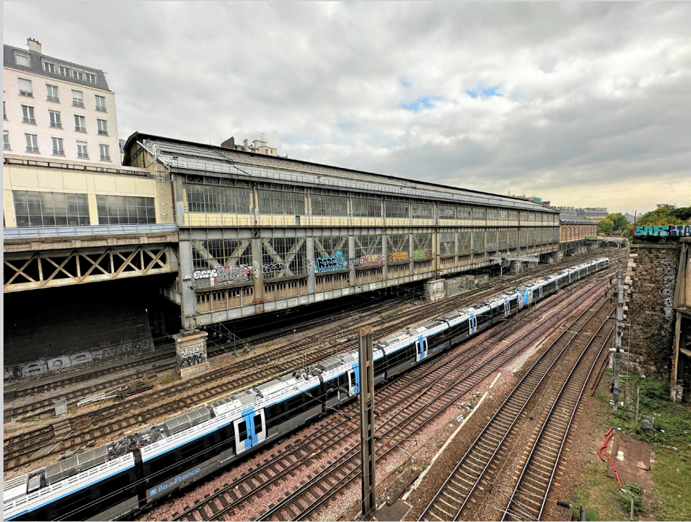
Figure 2 - Photo de la halle dite «des Batignolles» qui surplombe les voies, © photo personnelle
