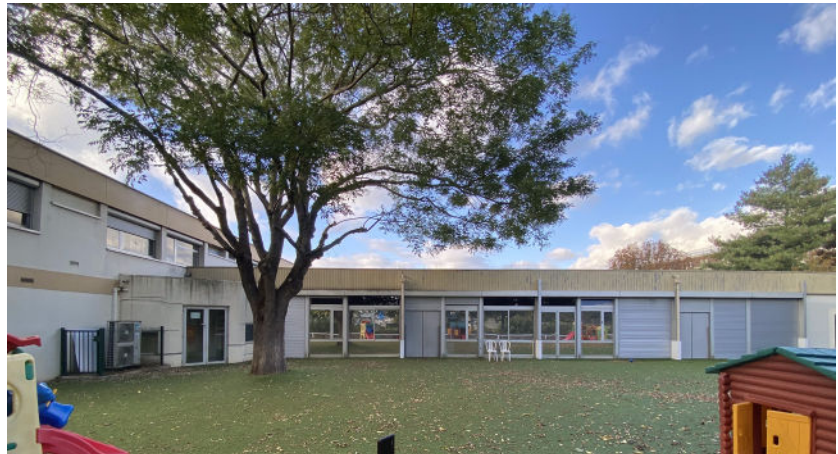
Fig 37. AYDIN C.K . (2023) Photo de la façade Sud de la crèche
