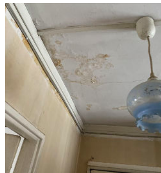
Fig 08. AYDIN C.K , (2022), Série de photos témoignant de pathologies dû à l'humidité
