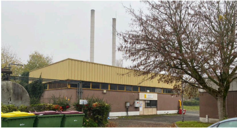
Fig 42. AYDIN C.K . (2023) Photo de la façade Nord de la Chaufferie
