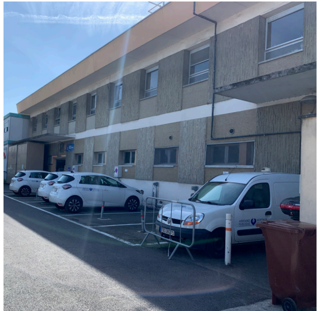
10. Photographie Bâtiment 8, de A.O.
