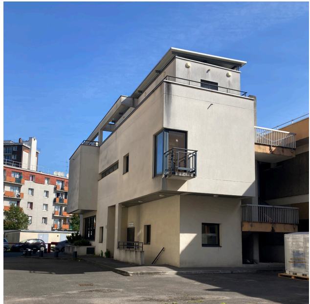
21. Photographie Bâtiment 17 E.D.
