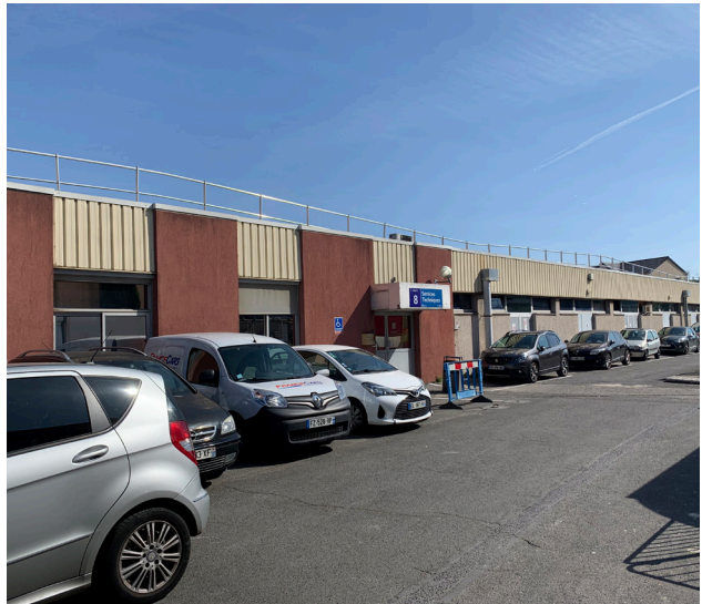
20. Photographie Bâtiment 16 A.O.
