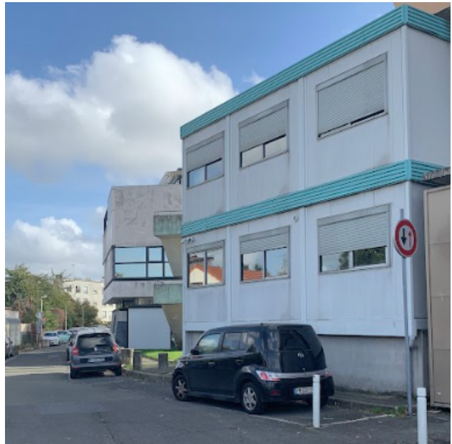
22. Photographie Bâtiment 18 de A.O.
