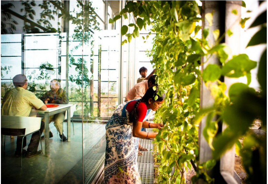
16. Photographie de la façade végétalisée du bâtiment KMC Corporate Office, RMA Architects, Inde.
