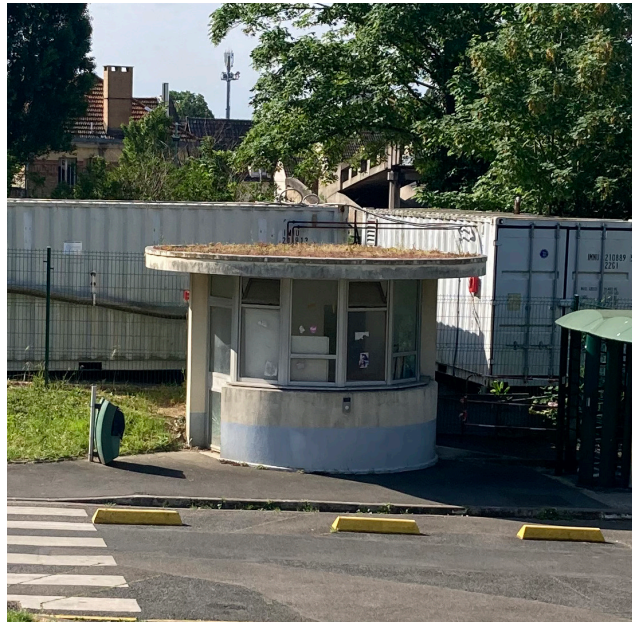
15. Photographie Bâtiment 12, E.D.
