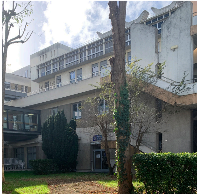
11. Photographie Bâtiment 9, de A.O.
