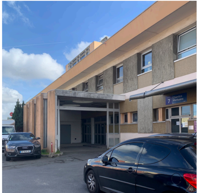
9. Photographie Bâtiment 7, de A.O.
