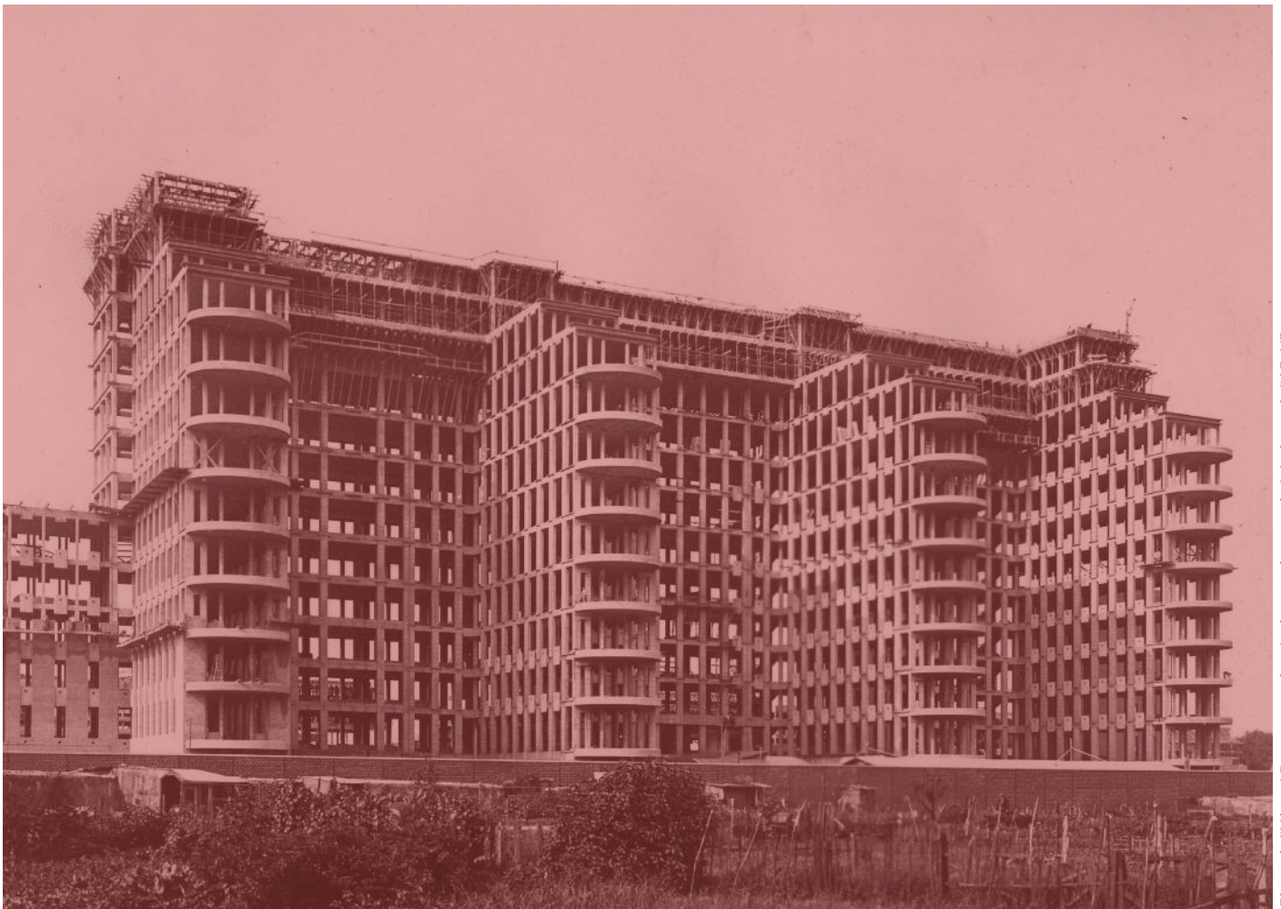
Photo de l'Hôpital Beaujon pendant le chantier (vers 1933). © Archives de l'AP-HP
